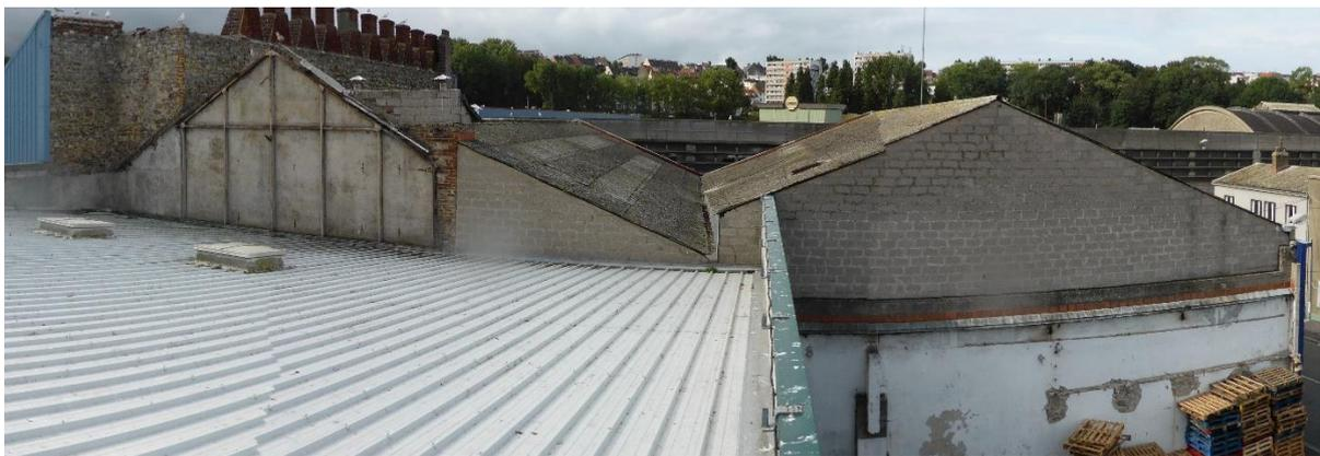
En l'absence de données sur le degré coupe-feu de murs en moellons , nous considérons que ce mur séparatif est assimilable à un mur en briques. Les matériaux constituant le corps du mur sont soit des briques pleines soit des pierres. Ces deux matériaux sont pleins et inertes. Les joints sont soit à la chaux soit au ciment. Ces deux types de joints sont inertes.
